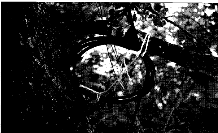
Il est vivement conseillé d'empêcher la câble coaxial de rayonner. Pour cela, quelques spires dans le câble, près du point d'alimentation, sont de rigueur.
