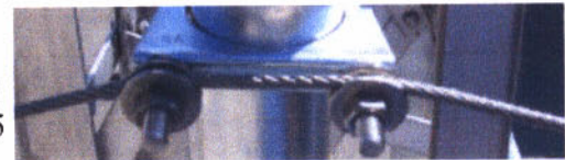
Ansicht zentrale und äußere Boomabspannung für OB11-3 / view centre and outer boom truss for OB11-3
