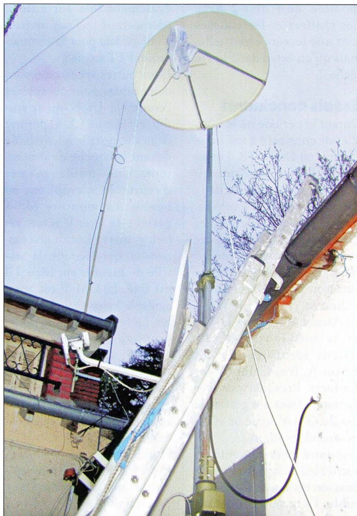
Une vue globale de l'installation de la parabole avec un AR300.
